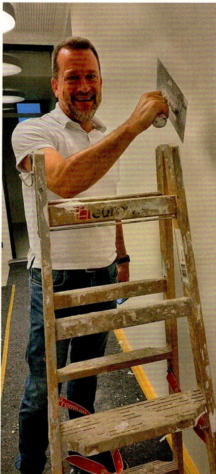
Mit der Putzkelle beseitigt Markus Gelderblom letzte Unebenheiten.
